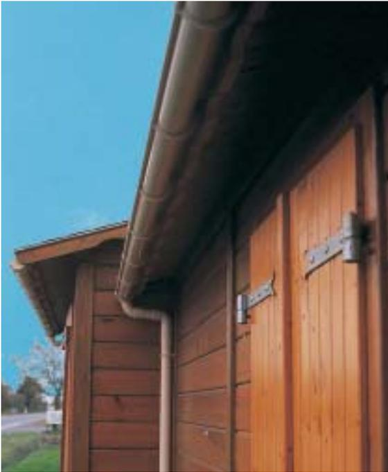
Conçue pour les couvertures de petite surface, cette gouttière à joints, très simple à poser, est adaptable à la plupart des matériaux de couverture.
